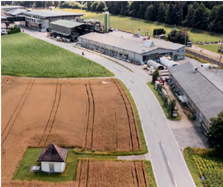
Fig. 4 : L'agriculture, la route, les voies, et les bâtiments trop proches compromettent le captage d'eau potable à Ramsei (photo : Sarah Liechti)
