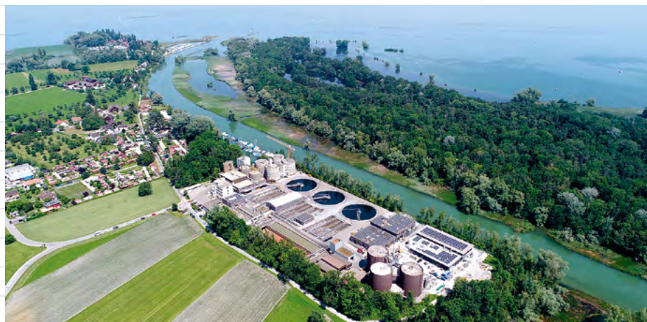
Fig. 10: Station d'épuration d'Altenrhein à l'embouchure du Vieux Rhin dans le lac de Constance, 2020 (photo: syndicat de traitement des eaux d'Altenrhein)
